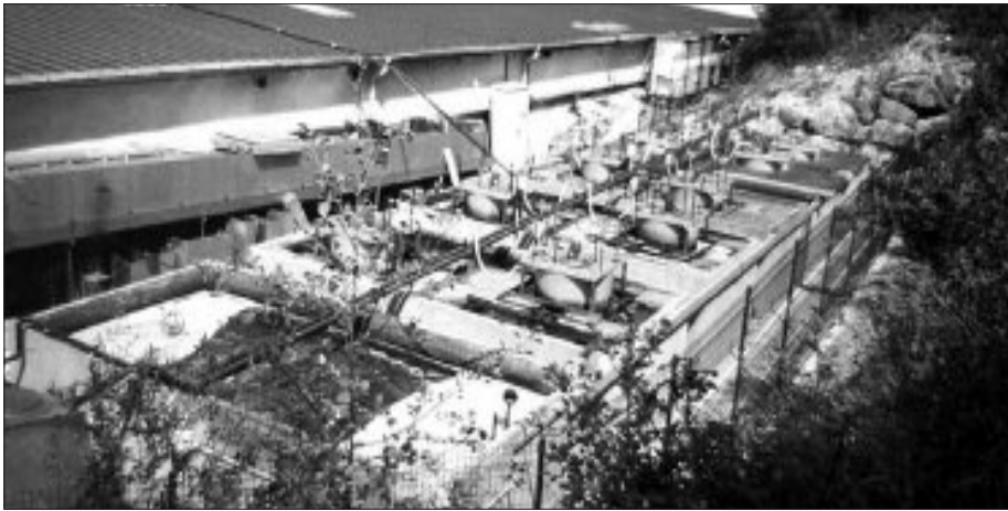
La station d'épuration de l'usine qui n'a jamais été efficace en dépit d'un appareillage imposant au tout début
