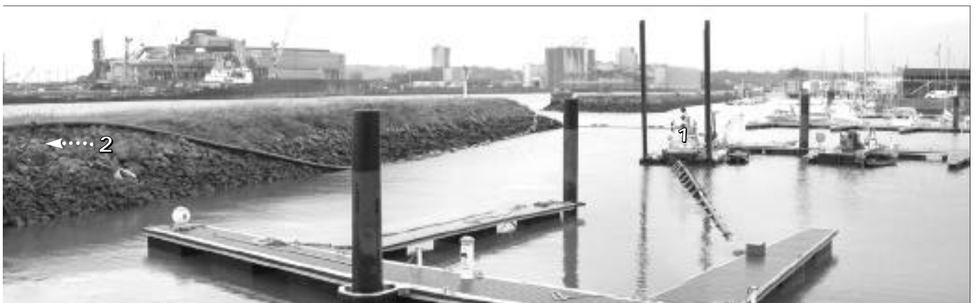
On distingue sur la photo la plateforme de dragage (1) ainsi que le tuyau (2) qui achemine les boues... vers l'Adour !
